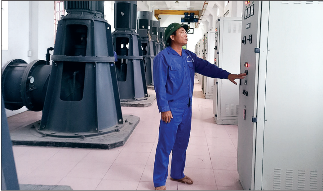
Công nhân Công ty TNHH MTV Khai thác công trình thủy lợi Bắc kiểm tra máy móc chuẩn bị lấy nước ở ải.
