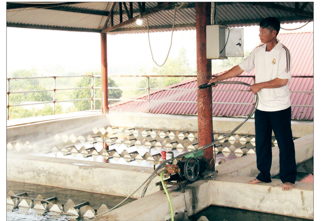
Công nhân Công ty Cổ phần Nước sạch Hưng Hà thực hiện quy trình rửa bể chứa nước.
