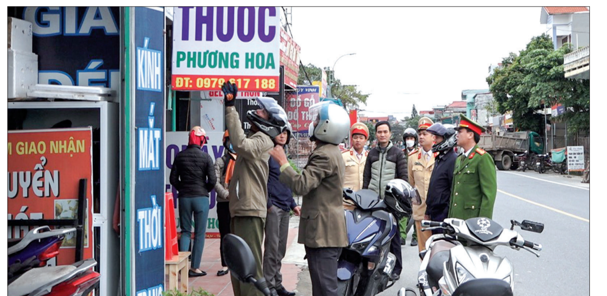
Lực lượng chức năng huyện Thái Thụy tháo dỡ biển quảng cáo vi phạm hành lang an toàn giao thông trên địa bàn xã Thái Xuyên.
