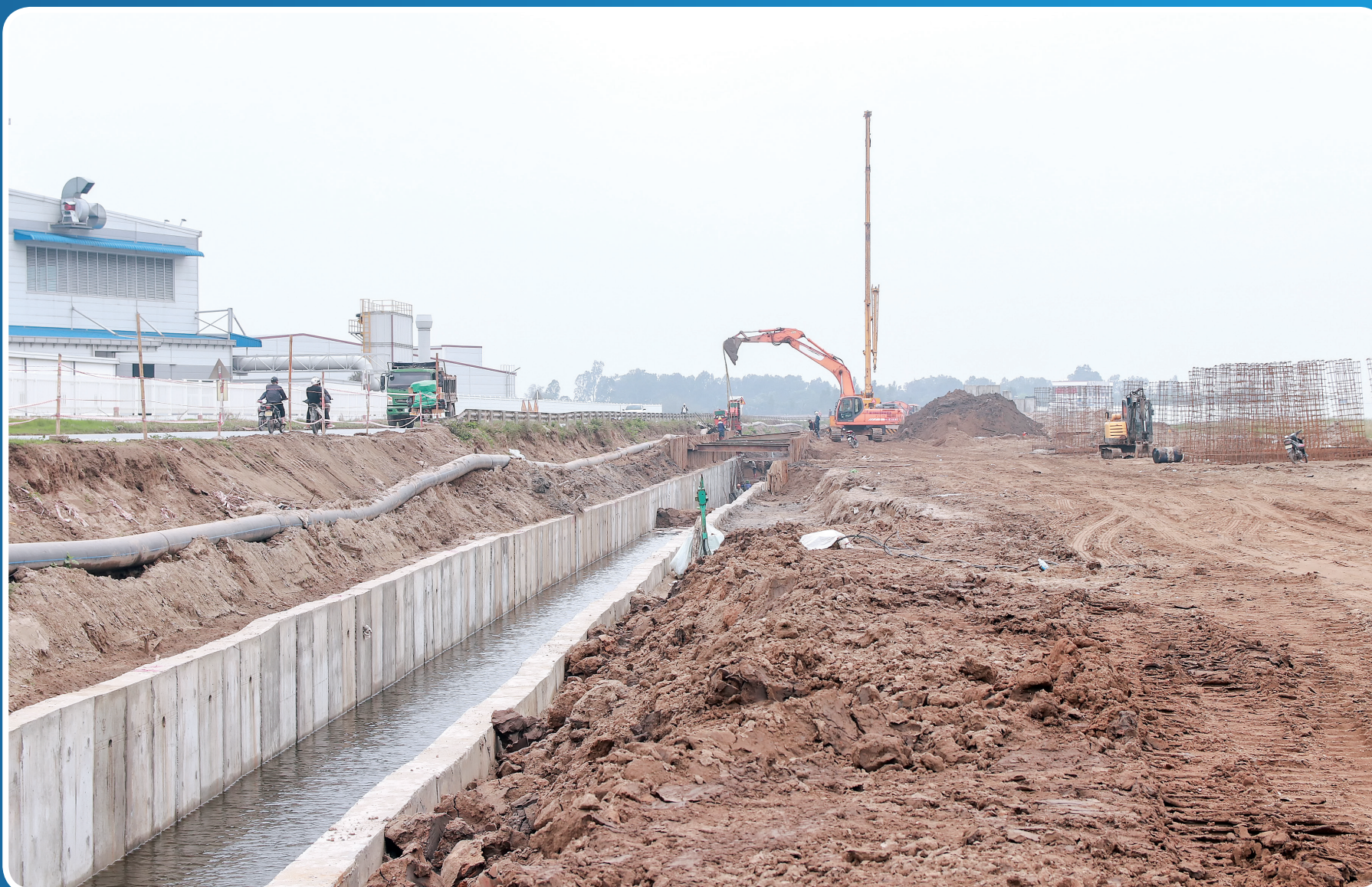
Thi công tuyến số 1, tuyến đường trục kết nối Khu kinh tế Thái Bình tại huyện Thái Thụy.
