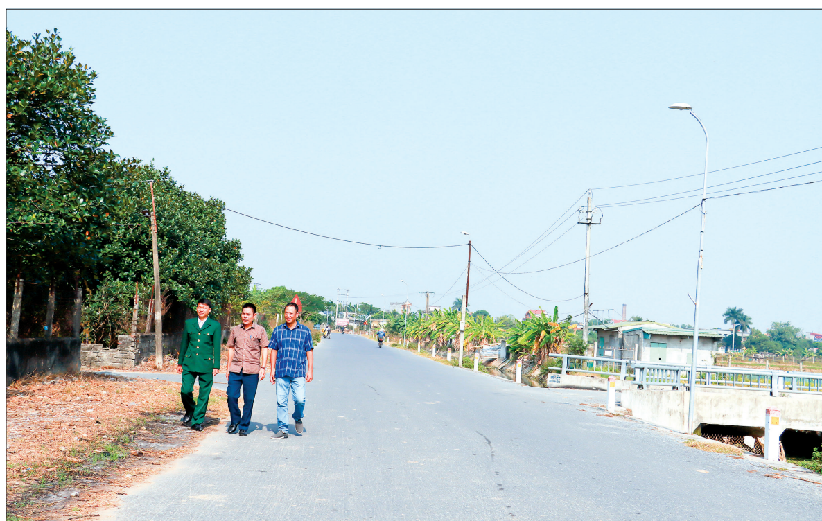
Đường cứu hộ, cứu nạn xã Đông Quan được mở rộng đáp ứng nhu cầu đi lại của nhân dân và phục vụ công tác cứu hộ, cứu nạn.
