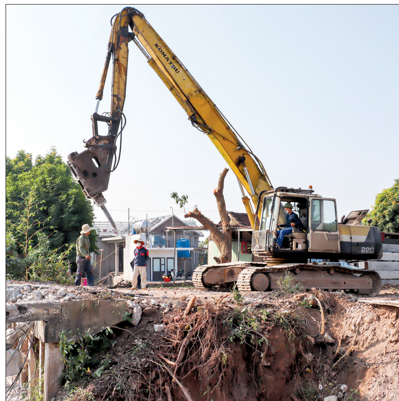
Cầu Lan xã Đông Vinh được xây mới thay cho cây cầu cũ đã xuống cấp.
