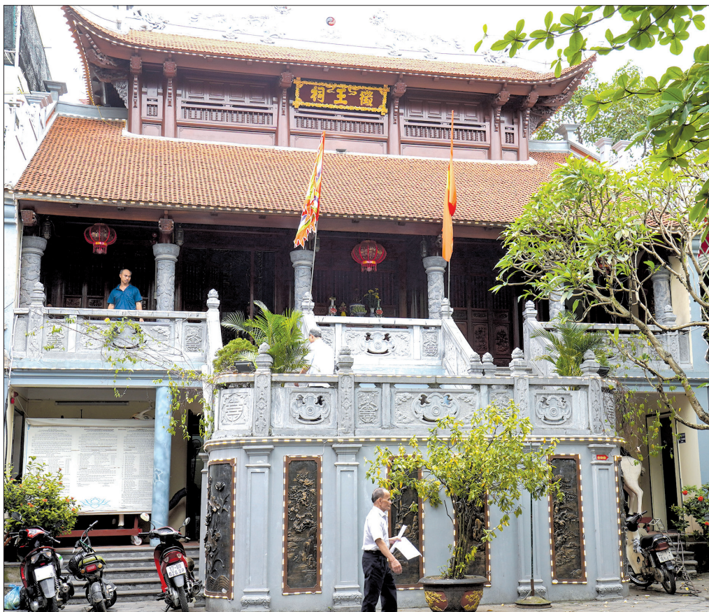
Đền Hai Bà Trưng, phường Đề Thám (thành phố Thái Bình).
