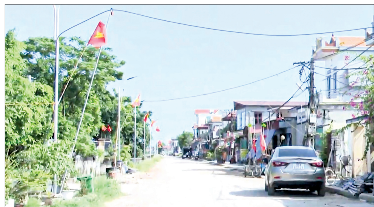
Nhờ làm tốt công tác tuyên truyền, vận động nên công tác giải phóng mặt bằng tuyến đường ĐH.95 đoạn qua địa bàn xã Thụy Dân chỉ trong 3 tháng đã hoàn thành.
