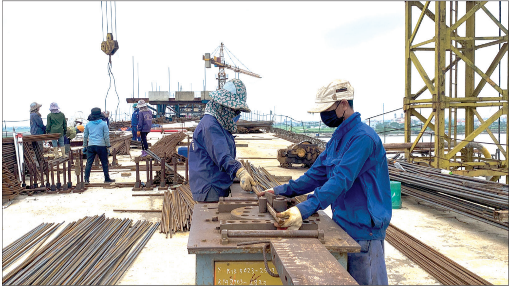
Trên công trường thi công cầu sông Hồng.
