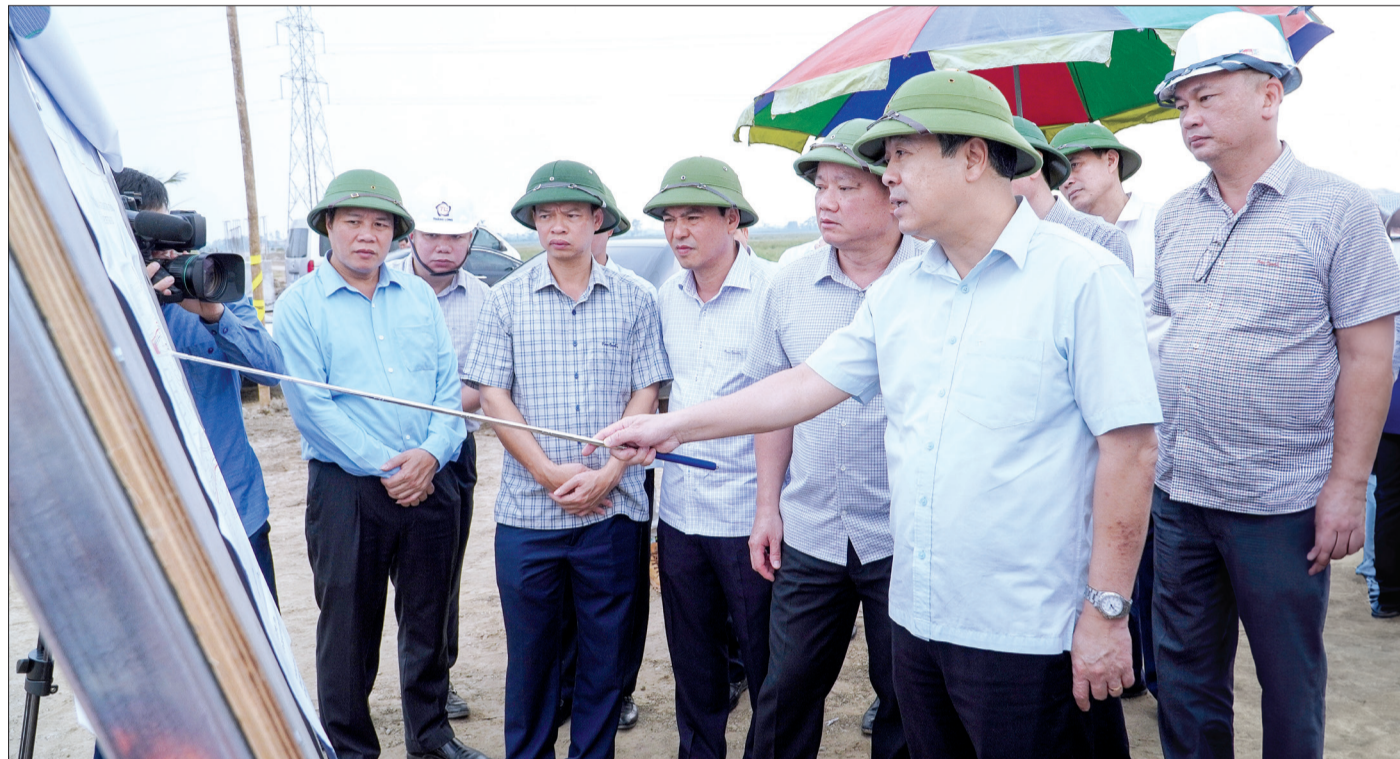
Đồng chí Ngô Đông Hải, Ủy viên Ban Chấp hành Trung ương Đảng, Bí thư Tỉnh ủy cùng các đồng chí lãnh đạo tỉnh kiểm tra, chỉ đạo công tác đầu tư hạ tầng khu công nghiệp Thaco - Thái Bình.
