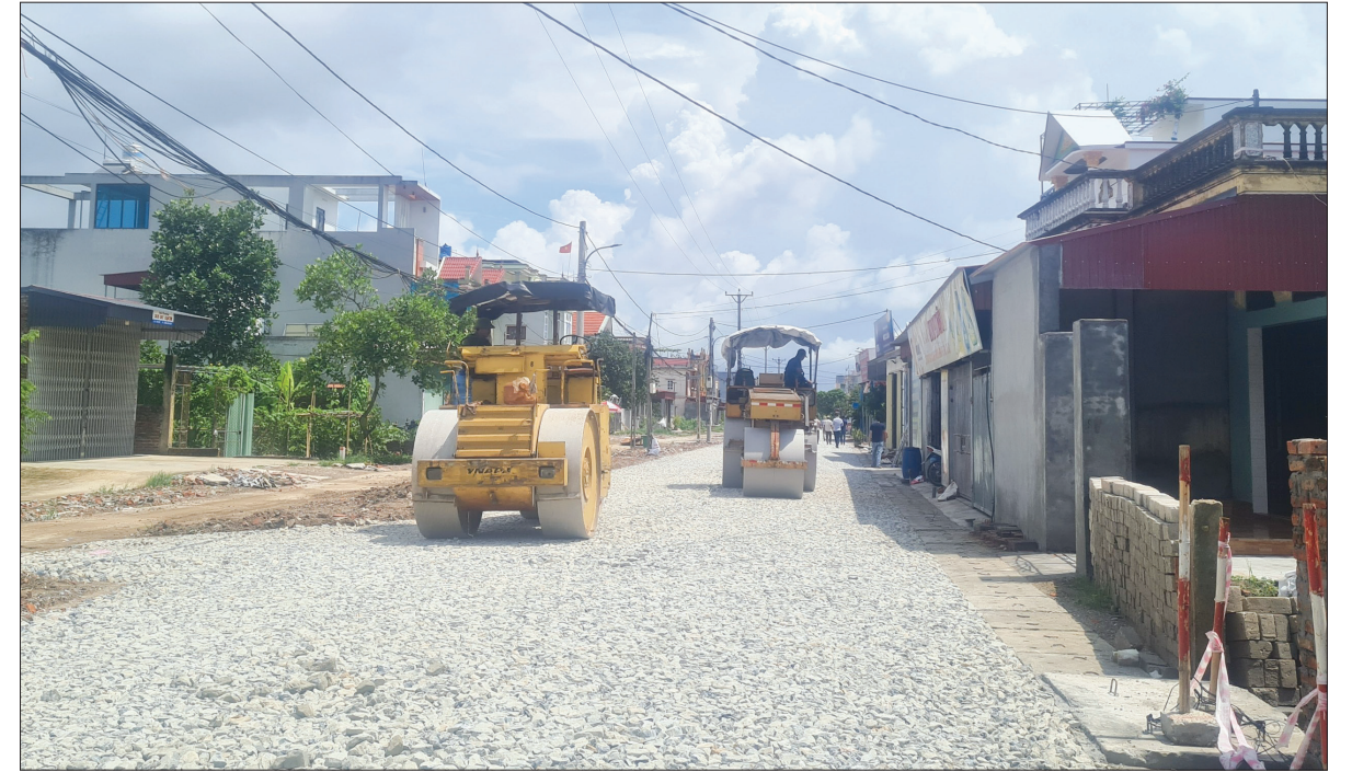
Thi công tuyến đường ĐH.90 đoạn qua xã Thụy Hưng.
