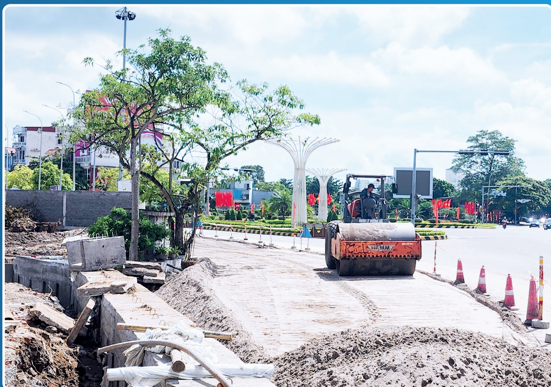
Đẩy nhanh tiến độ thi công hạ tầng khu dân cư thuộc phường Phú Khánh (thành phố Thái Bình).
