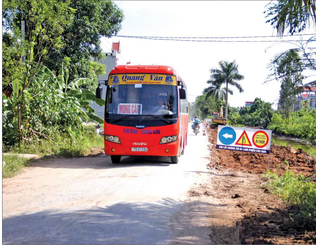
Những đoạn đã bàn giao mặt bằng, đơn vị thi công tiến hành cắm biển báo hiệu và tổ chức thi công.
