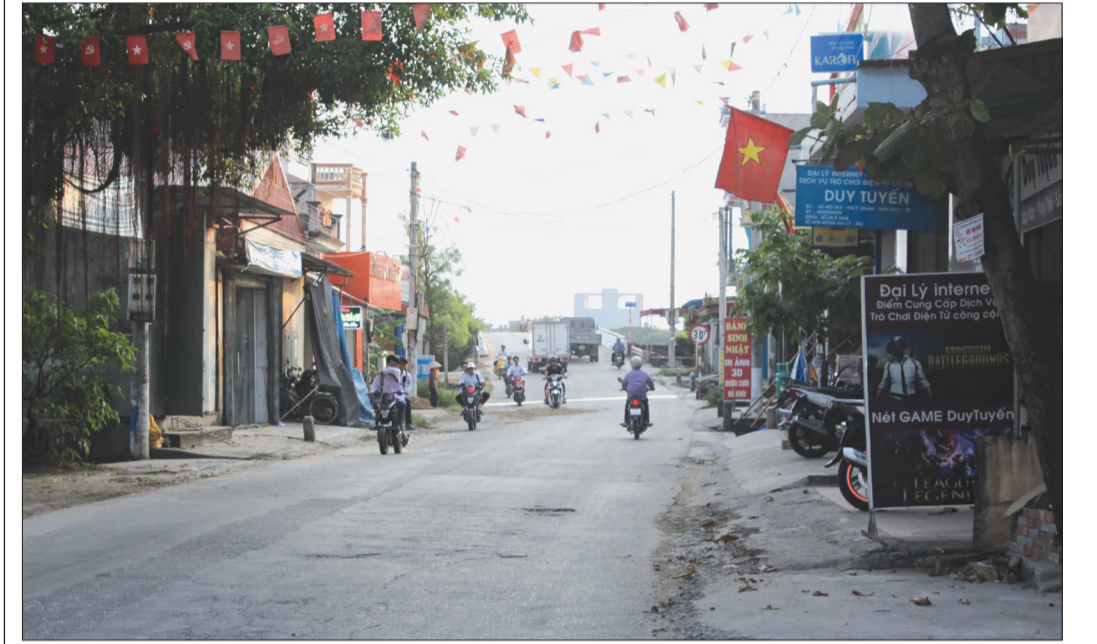
Đường ĐT.456 đoạn gần cầu Vô Hối hiện chưa thể thi công do vướng mắc về mặt bằng.
