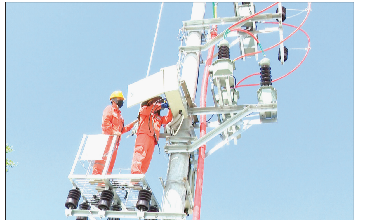
Công nhân Công ty Điện lực Thái Bình kiểm tra các vị trí tiếp xúc tại trạm biến áp.
