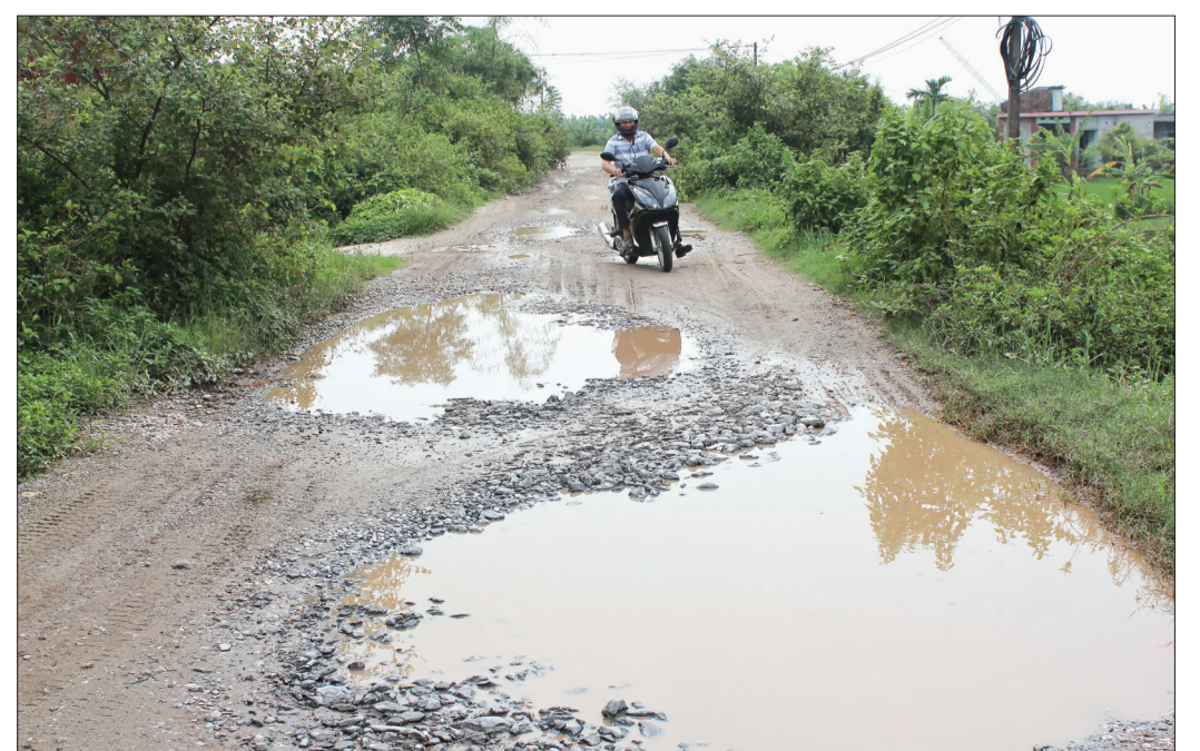
Mặt đê cửa sông Hữu Hóa đoạn từ K2+900 đến K7+000 nhỏ và có rất nhiều ổ voi, ổ gà.
