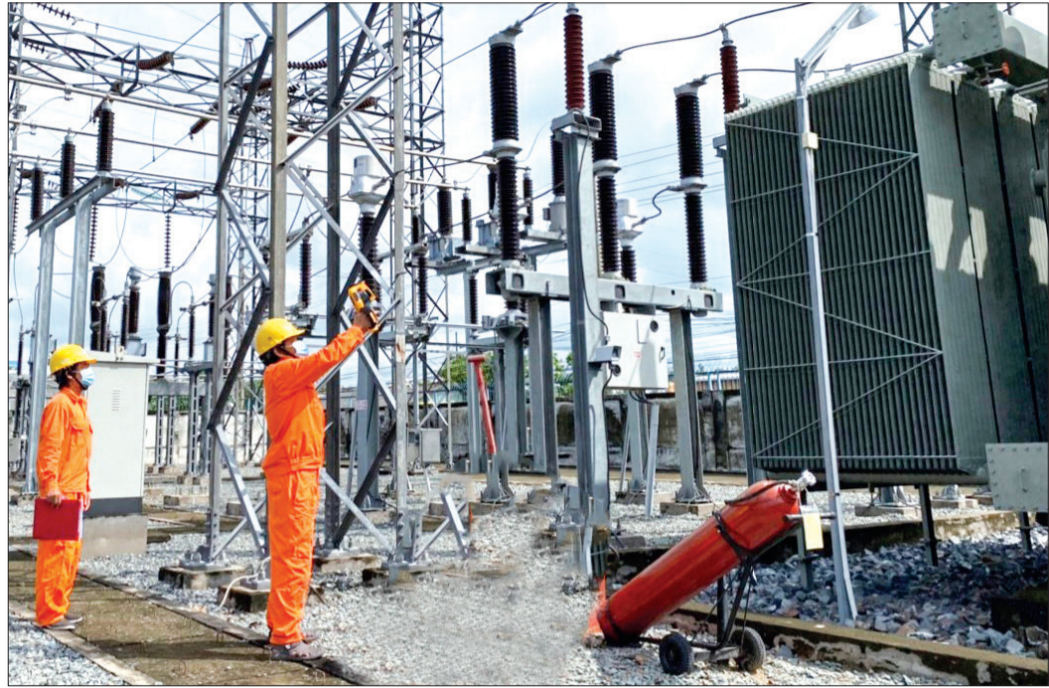
Công nhân Công ty Điện lực Thái Bình sử dụng camera nhiệt kiểm tra các vị trí mối nối, ngăn ngừa sự cố phát sinh trên lưới điện.
