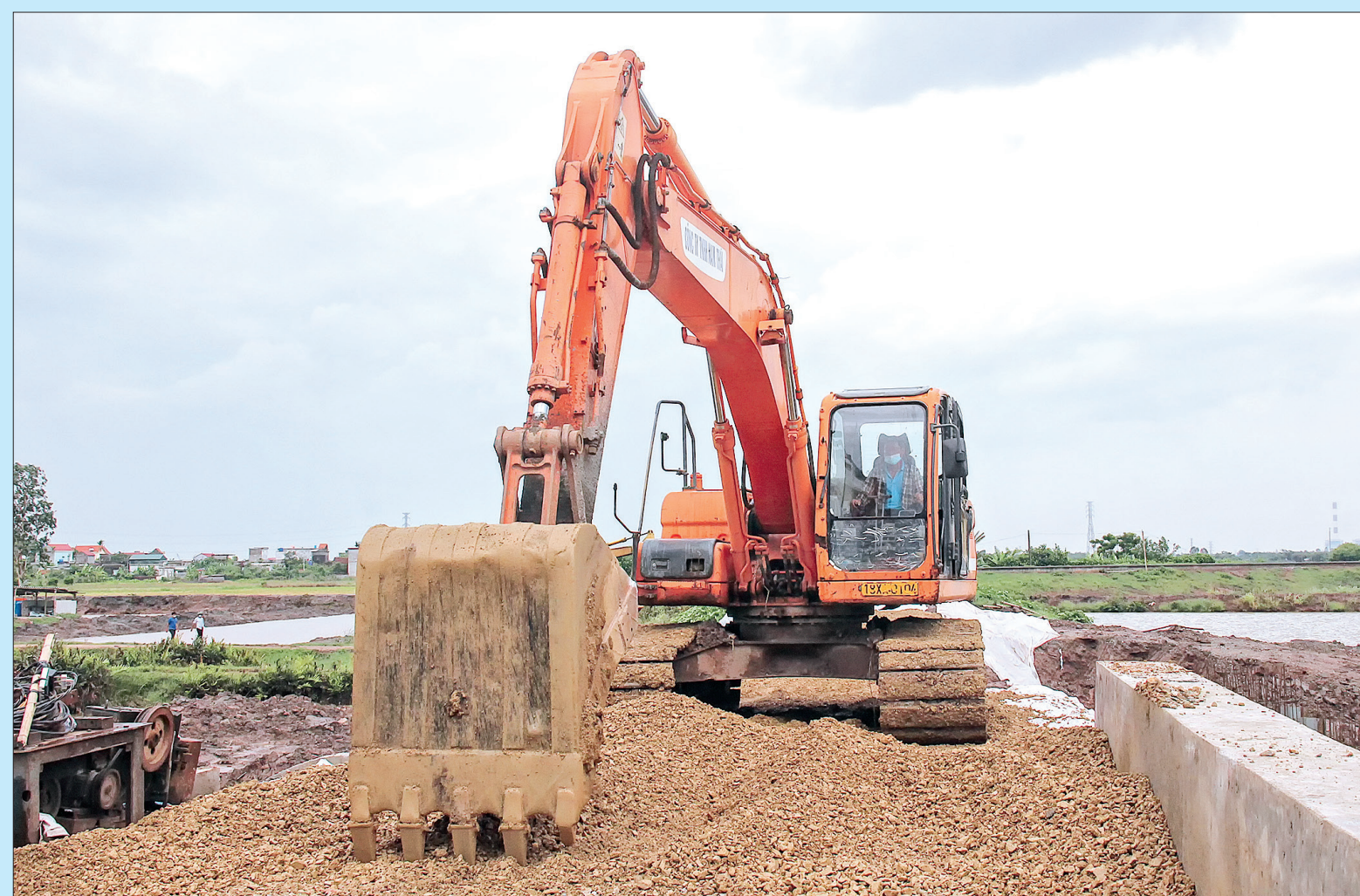
Thi công nâng cấp đê biển số 8, đoạn qua địa bàn thị trấn Diêm Điền (Thái Thụy).
