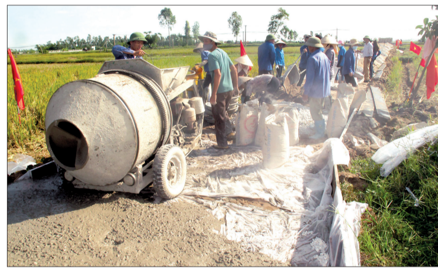
Xây dựng cơ sở hạ tầng nông thôn mới tại xã Thụy Phong (Thái Thụy).
