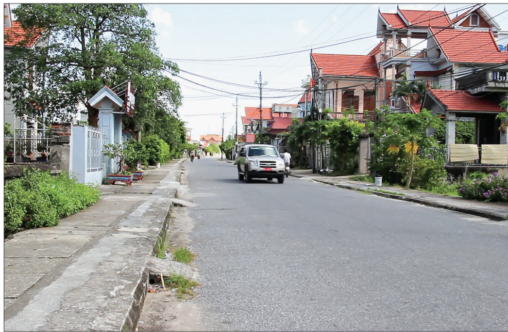
Đường giao thông trên địa bàn huyện Tiến Hải thông thoáng, sạch đẹp.
