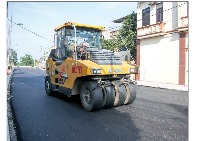
Thi công đường Đinh Tiên Hoàng, đoạn từ đường Lý Thường Kiệt đến đường quy hoạch số 5 khu tái định cư Đông Lôi (thành phố Thái Bình).
