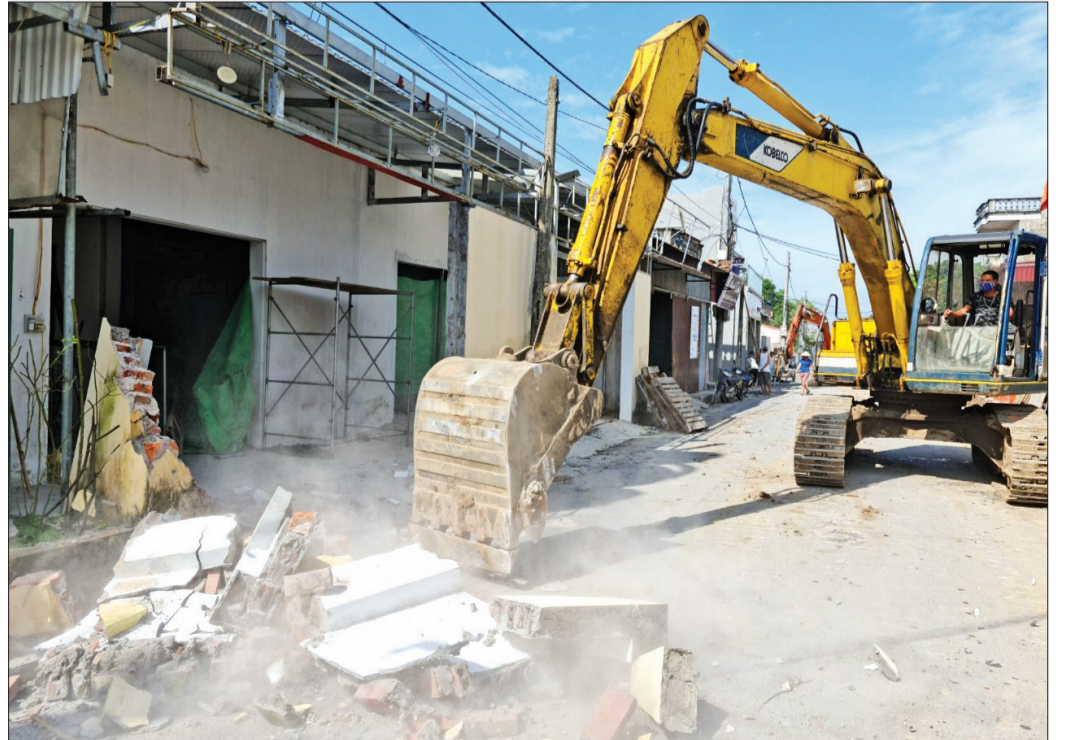
Người dân xã An Thái (Quỳnh Phụ) tự nguyện tháo dỡ công trình bàn giao mật bằng thi công tuyến đường.
