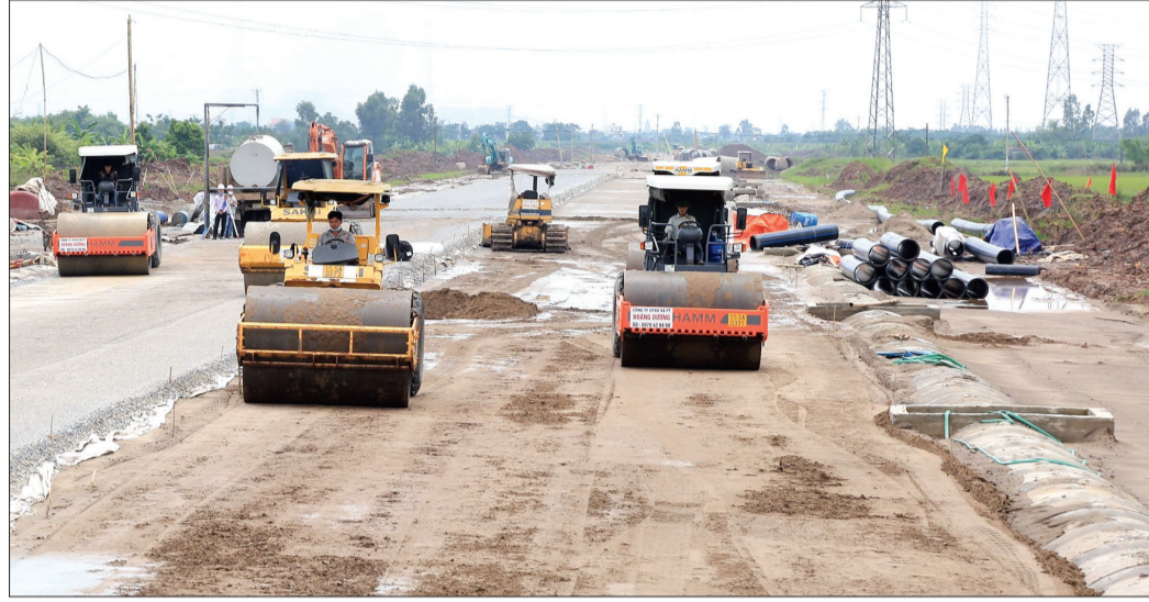
Hạ tầng giao thông tại khu công nghiệp Liên Hà Thái đang được đẩy nhanh tiến độ thi công.
