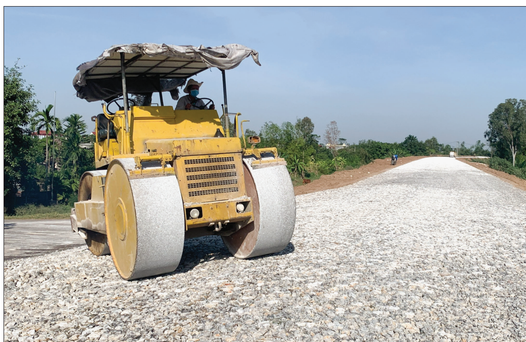
Thi công đê tả Trà Lý đoạn từ K2+900 đến K6+600.
