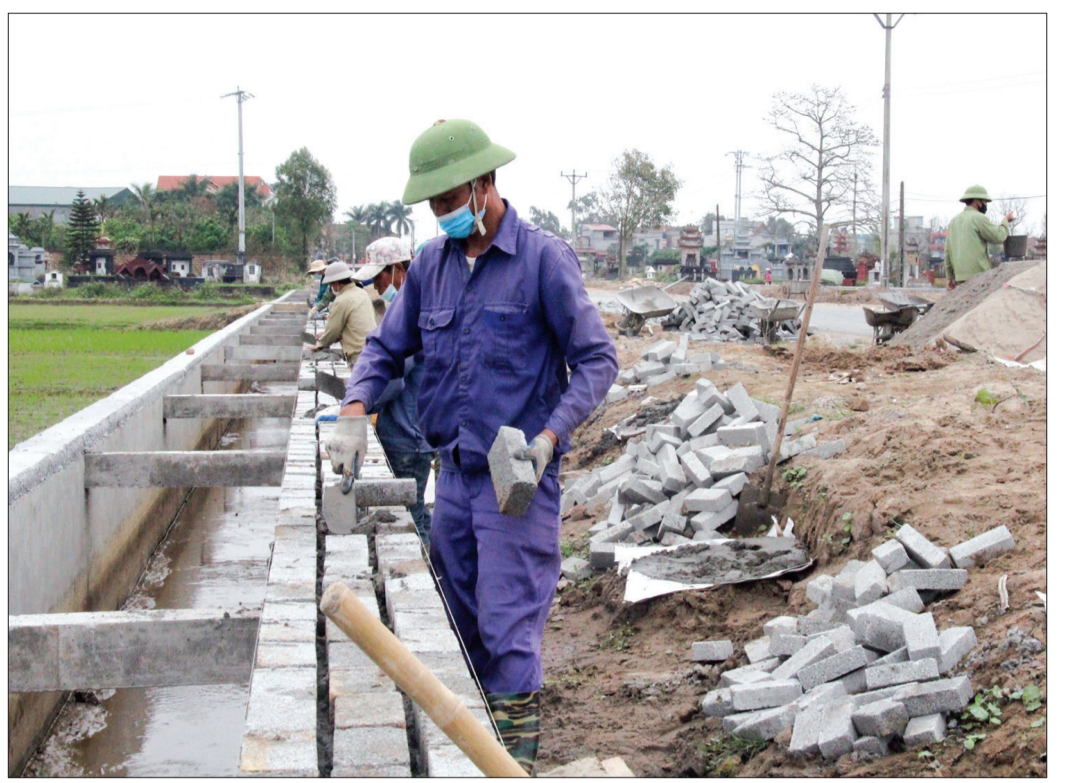
Thi công dự án đường vào khu lưu niệm nhà bác học Lê Quý Đôn.
