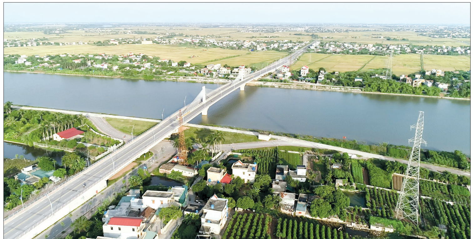
Cầu Vũ Đông bắc qua sông Trà Lý.
