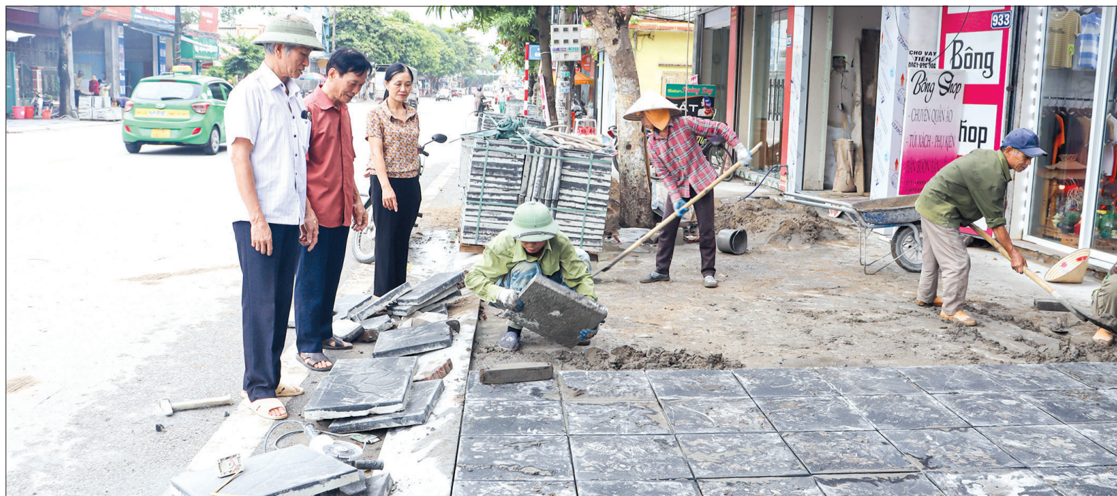
Cải tạo, nâng cấp vỉa hè tại thị trấn Kiến Xương.
