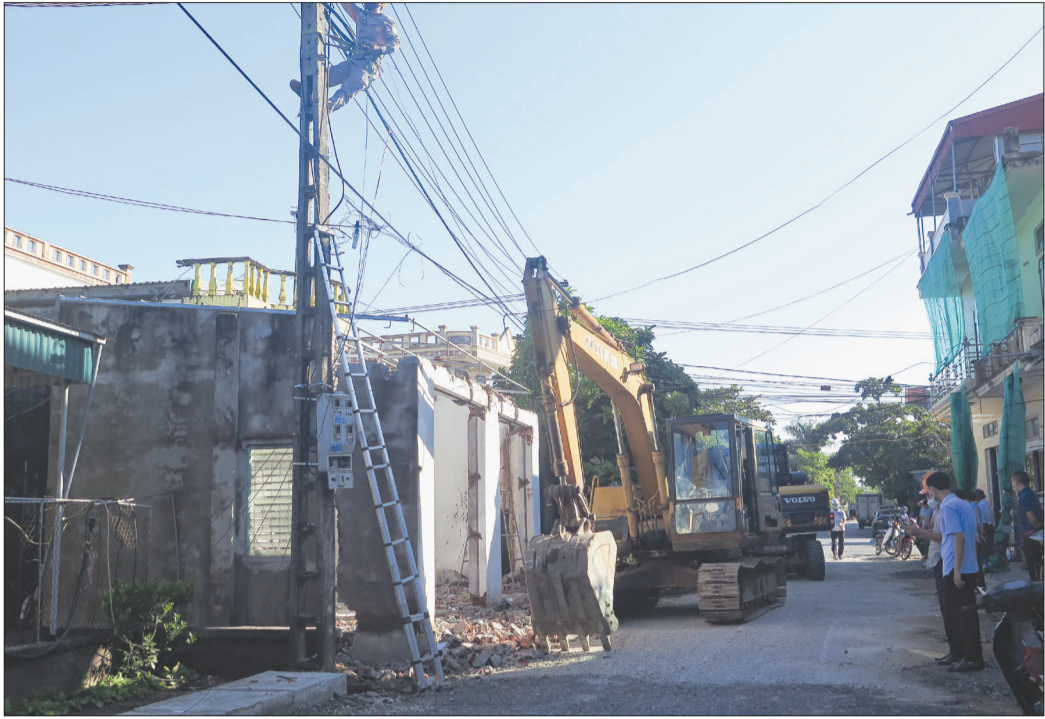
Giải phóng mặt bằng phục vụ thi công tuyến đường liên xã Hòa Bình - Đình Phùng.
