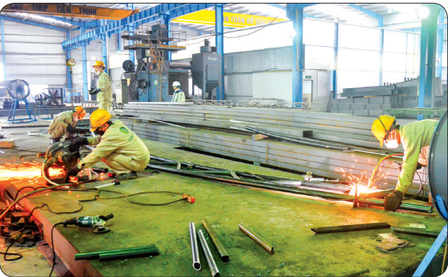
Nhà máy sản xuất của Công ty Cổ phần Phát triển đầu tư và Xây lắp Tiến Thịnh (khu công nghiệp Phúc Khánh, thành phố Thái Bình).
