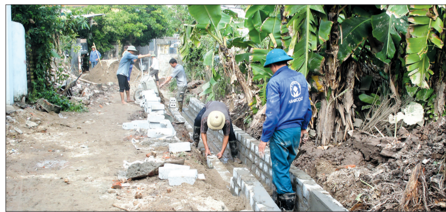
Xây dựng hệ thống thoát nước ở xã Chi Lăng (Hưng Hà).
