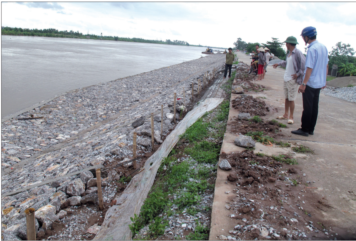
Kê Vũ Đông II (thành phố Thái Bình) đang gấp rút thi công.
