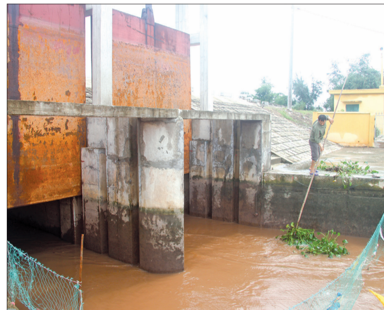
Công nhân Xí nghiệp Khai thác công trình thủy lợi huyện Tiên Hải thường xuyên vớt vật cản tại cửa cống để nước tiêu thoát tốt.
