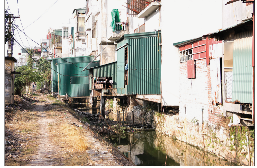
Tình trạng vi phạm hành lang công trình thủy lợi trên sông T6 đoạn qua địa bàn xã Vũ Hội (Vũ Thu) diễn ra phổ biến.
