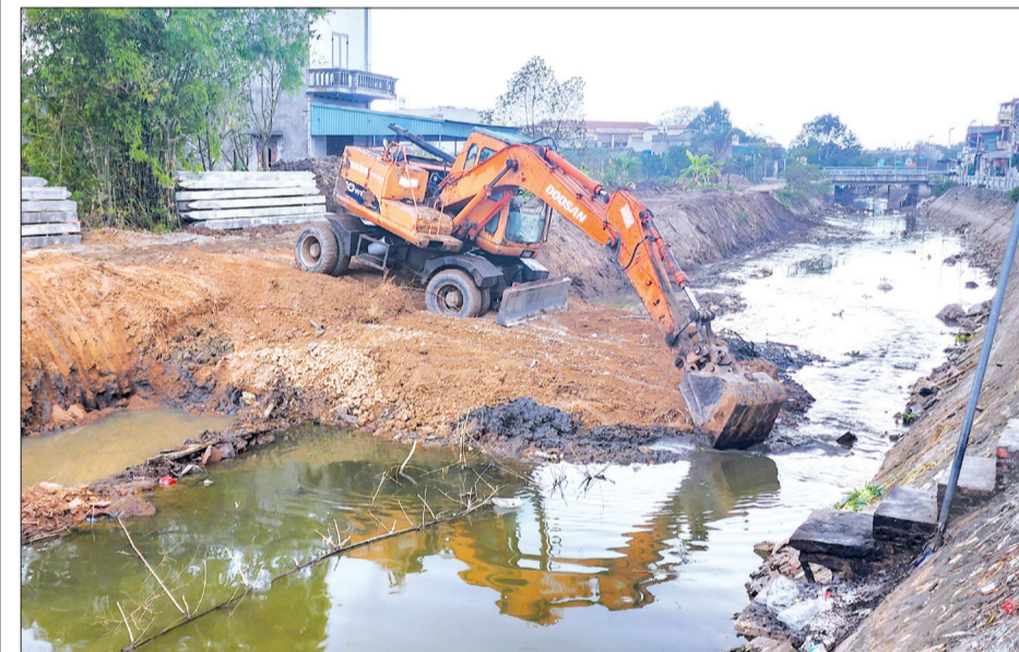
Thi công kênh sông 223 đoạn qua xã Minh Hòa (Hưng Hà).
