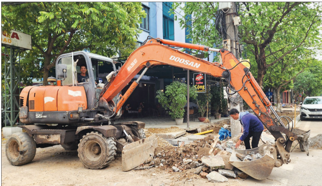
Thi công tuyến đường Trần Hưng Đạo.
