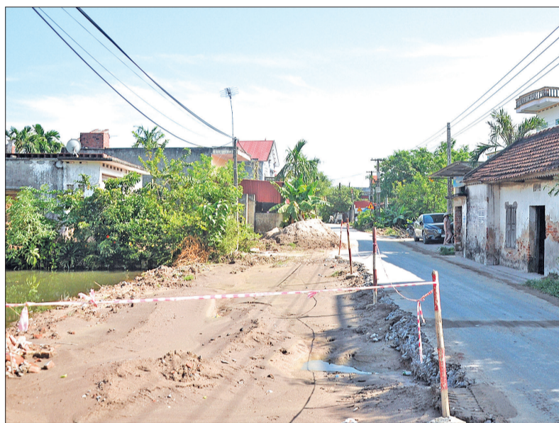
Đoạn vướng mắc giải phóng mặt bằng tại xã Thái Thịnh, dự án đường Thái Thủy - Thái Thịnh, huyện Thái Thụy, giai đoạn 2.
