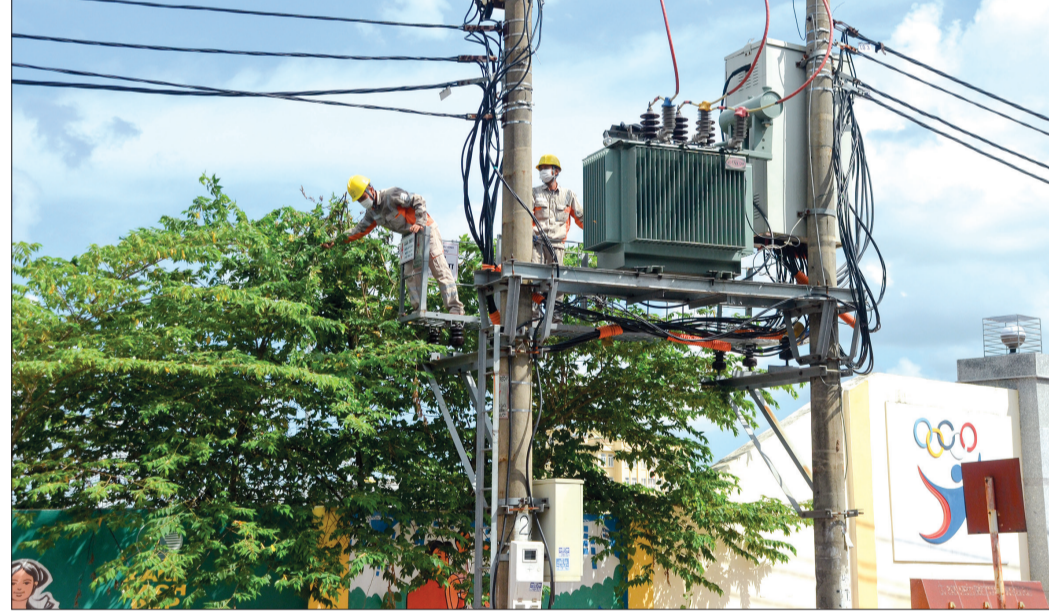
Điện lực Quỳnh Phụ tổ chức phát quang hành lang lưới điện để bảo đảm an toàn mùa mưa bão.
