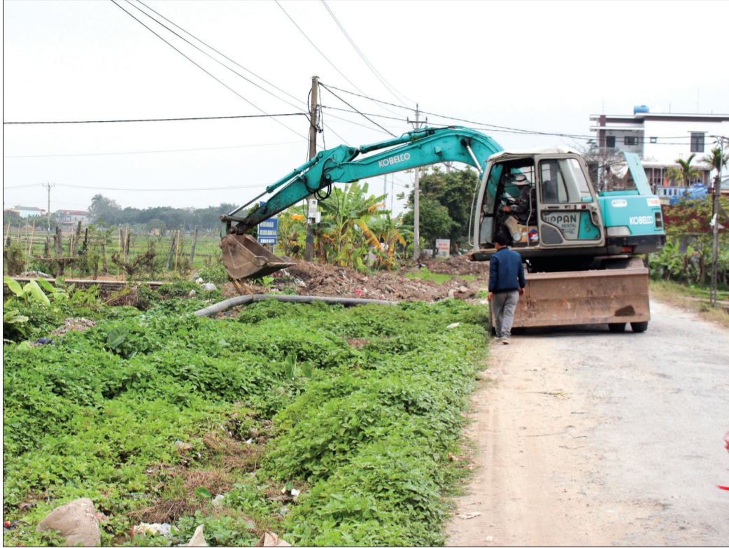
Thi công dự án đường ĐH.93 đoạn từ xã Thụy Trinh - Hống Dũng.
