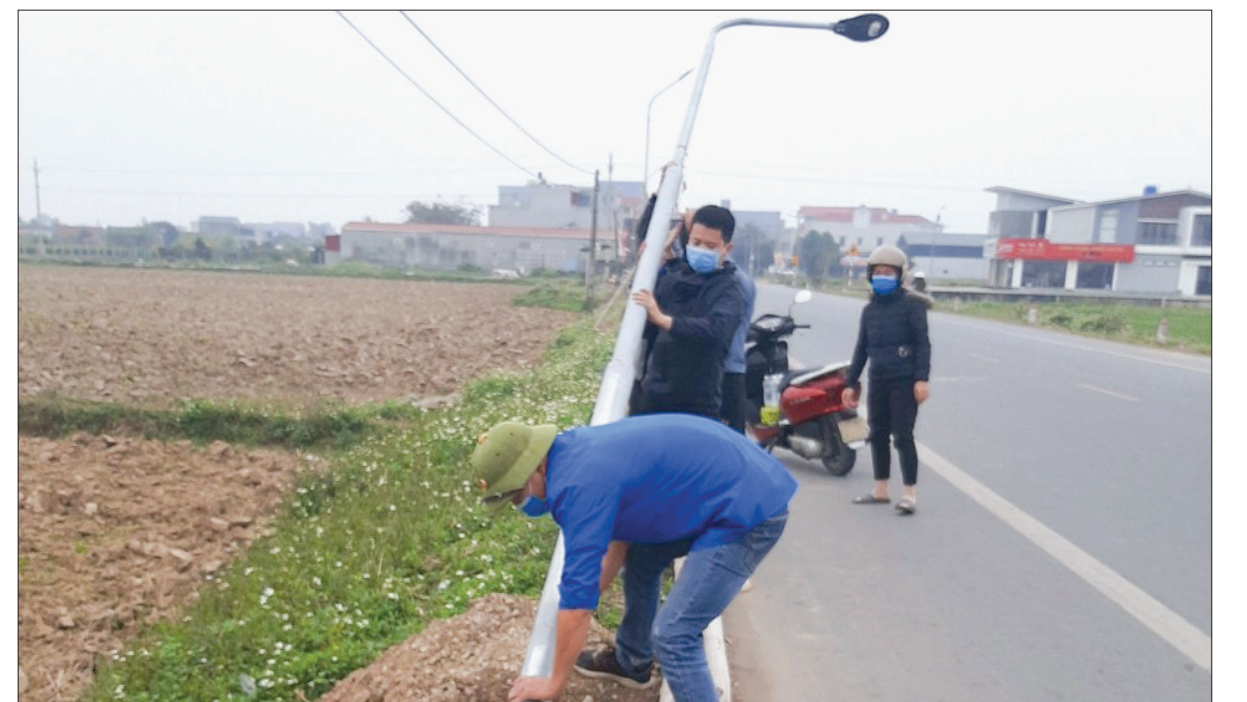
Đoàn Thanh niên xã Thụy Bình (Thái Thụy) xây dựng công trình thanh niên thấp sáng đường quê chào mừng đại hội đoàn các cấp.
