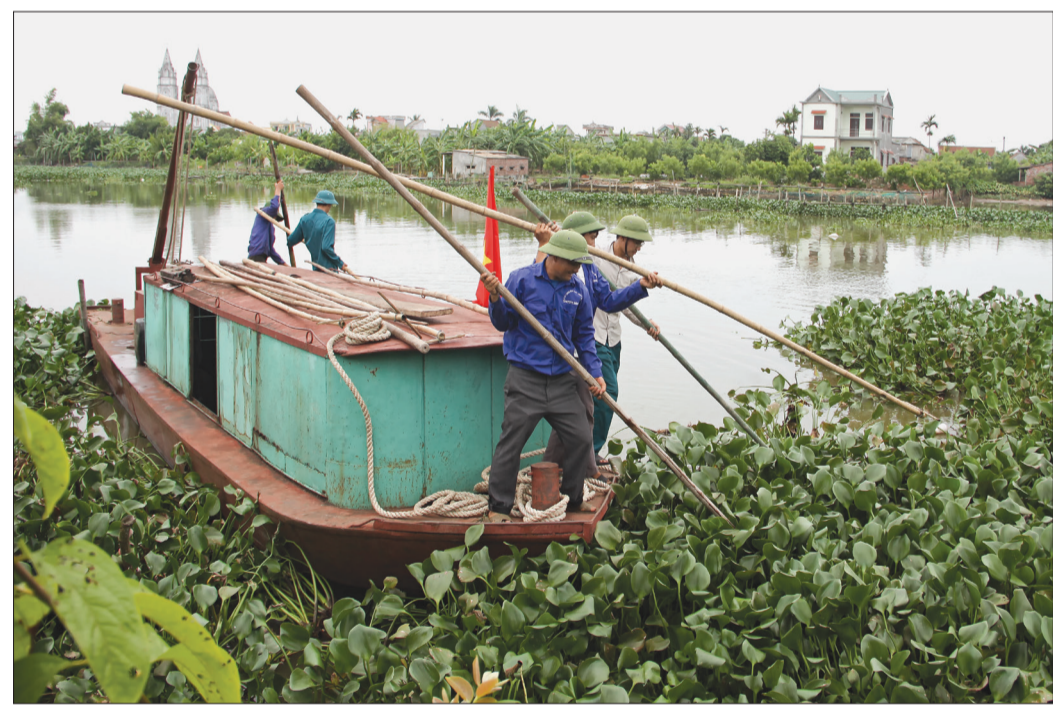
Công ty TNHH MTV Khai thác công trình thủy lợi Bắc Thái Bình tổ chức giải tỏa hành lang công trình thủy lợi trên sông Diêm Hộ.
