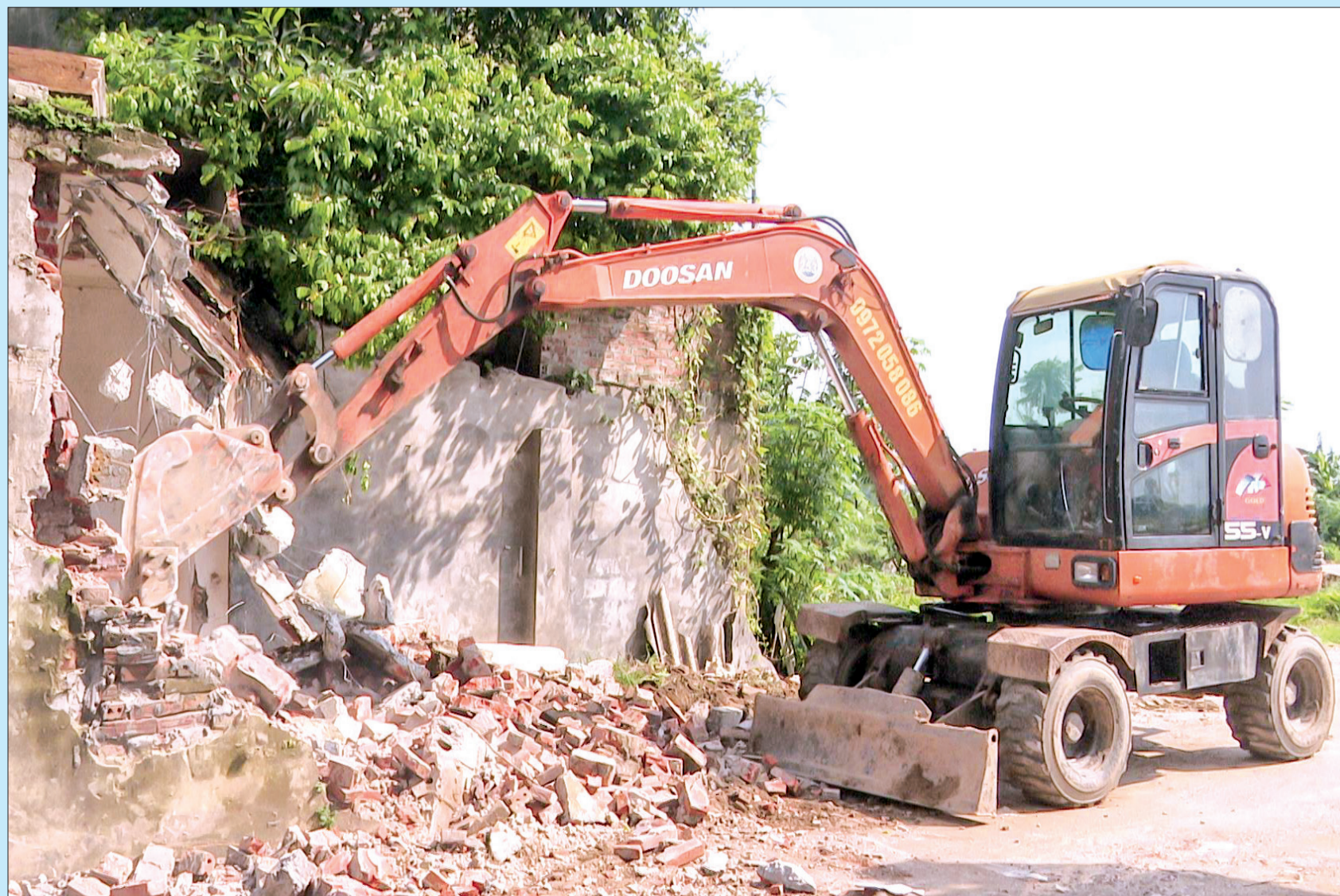
Người dân xã Vũ Quý (Kiến Xương) phá dỡ công trình, nhà ở, tạo thuận lợi cho triển khai thi công các dự án.
