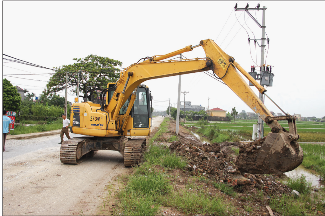
Thi công tuyến nhánh điều chỉnh số 3 đoạn qua địa phận xã An Thái (Quỳnh Phụ).
