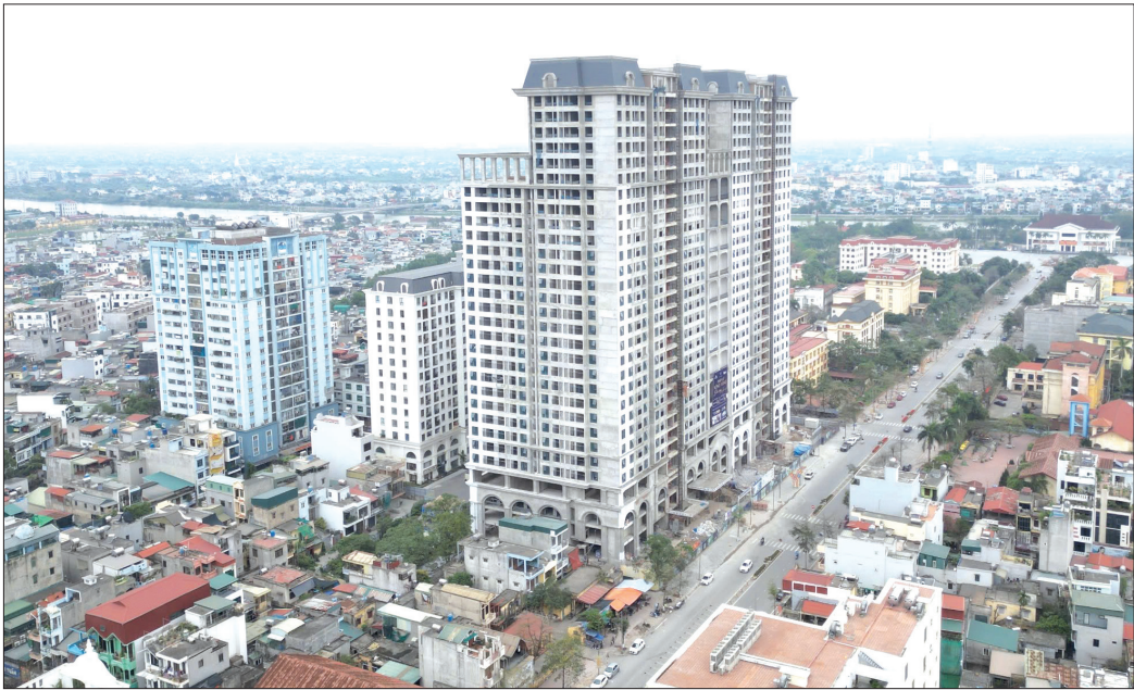
Nhiều dự án nhà ở đang được triển khai tại thành phố Thái Bình.
