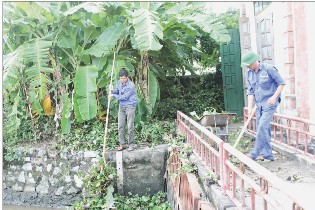
Công nhân trạm bơm Hệ, xã Thụy Ninh (Thái Thụy) vét bèo bọng giải phóng dòng chảy.
