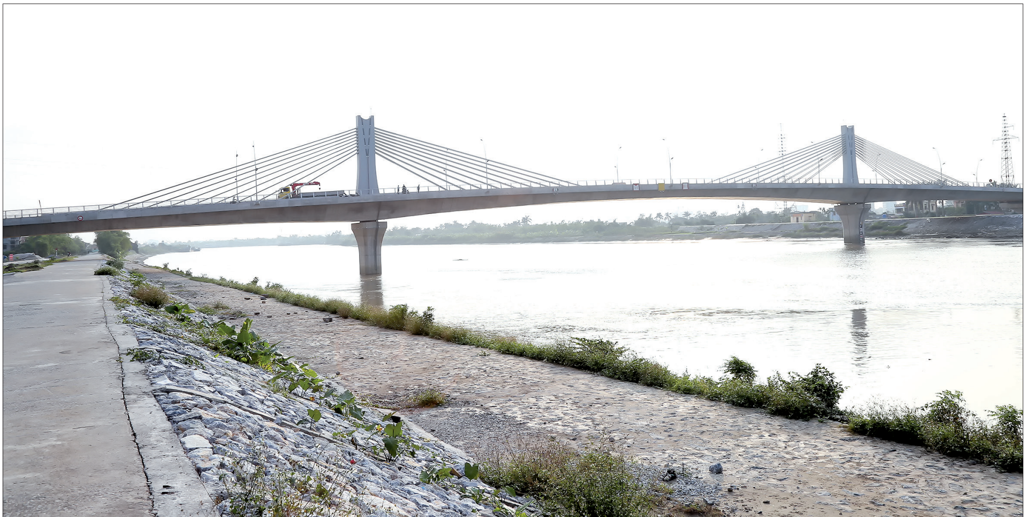
Cầu vượt sông Trà Lý.
