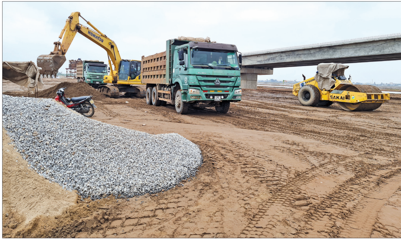
Không khí lao động trên công trường thi công cầu vượt sông Trà Lý thuộc dự án tuyến đường bộ ven biển.
