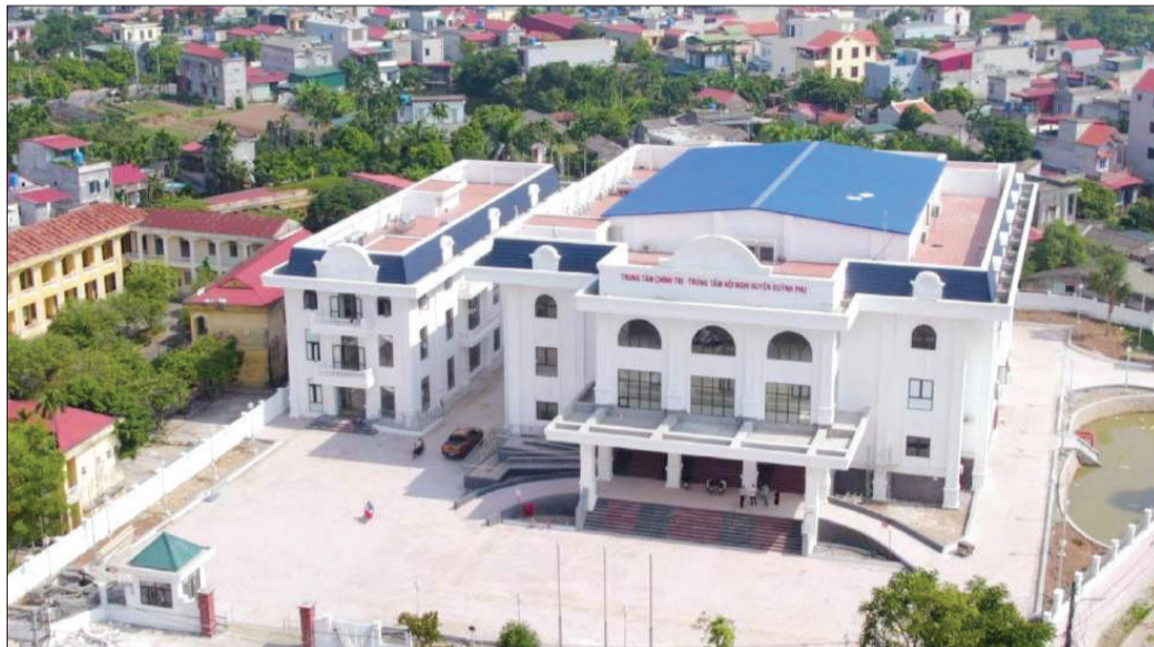
Trung tâm Chính trị - Trung tâm hội nghị huyện Quỳnh Phụ hoàn thiện và đưa vào sử dụng đáp ứng yêu cầu tổ chức hội nghị và các hoạt động chung của huyện.
