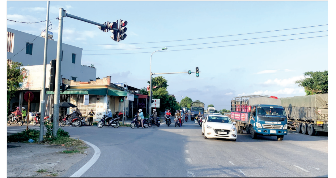
Mặc dù đã được lắp đặt hệ thống đèn tín hiệu giao thông nhưng khu vực ngã tư Khê Kiều thuộc điểm giao cắt giữa tuyến tránh S1, quốc lộ 10 với đường tỉnh ĐT.463 vẫn thường xuyên xảy ra va chạm, tai nạn giao thông.
