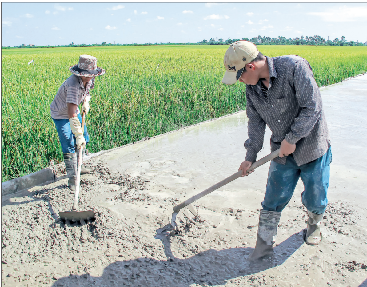
Xã Vũ Công (Kiến Xương) tiếp nhận xi măng hỗ trợ của tỉnh làm đường giao thông nội đồng.
