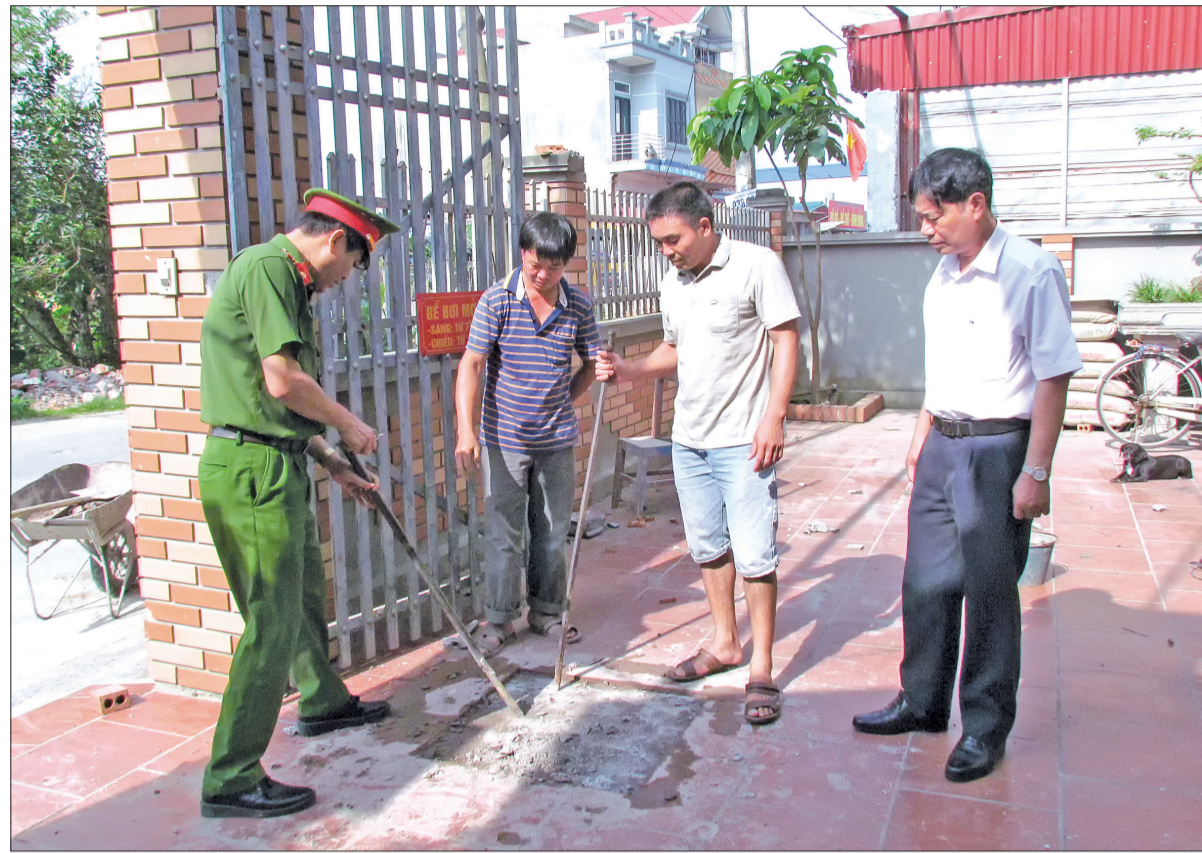
Người dân Hưng Hà tự tháo dỡ công trình vi phạm hành lang an toàn giao thông.
