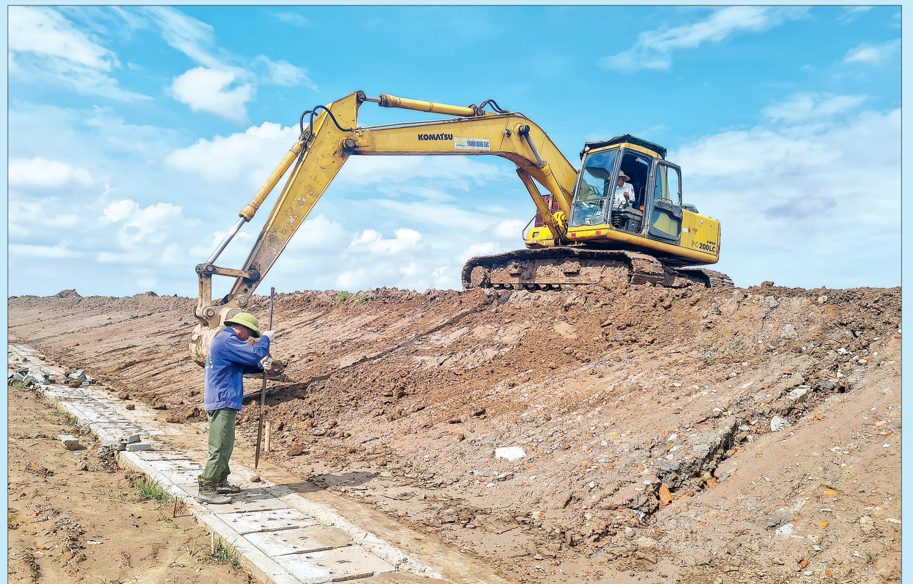
Thi công kè mặt trong đê Trà Lý.
