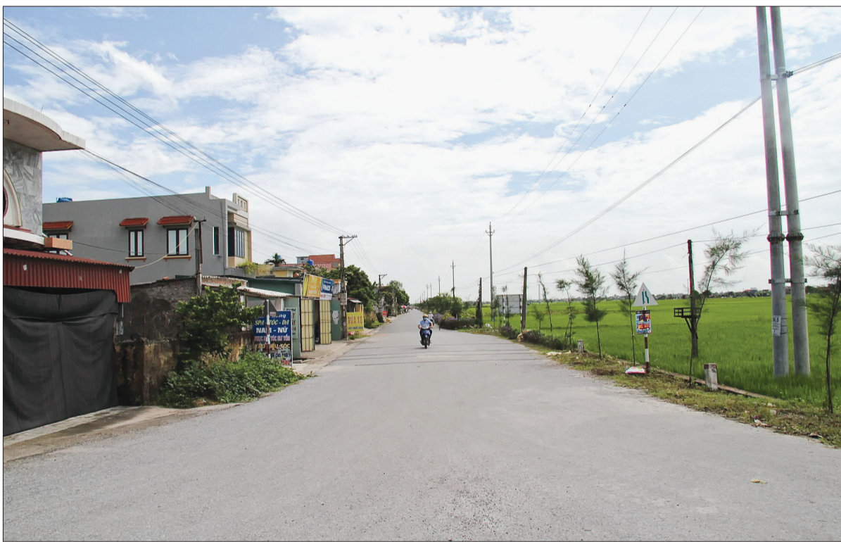
Đường vào trung tâm xã Hòa Bình được mở rộng.
