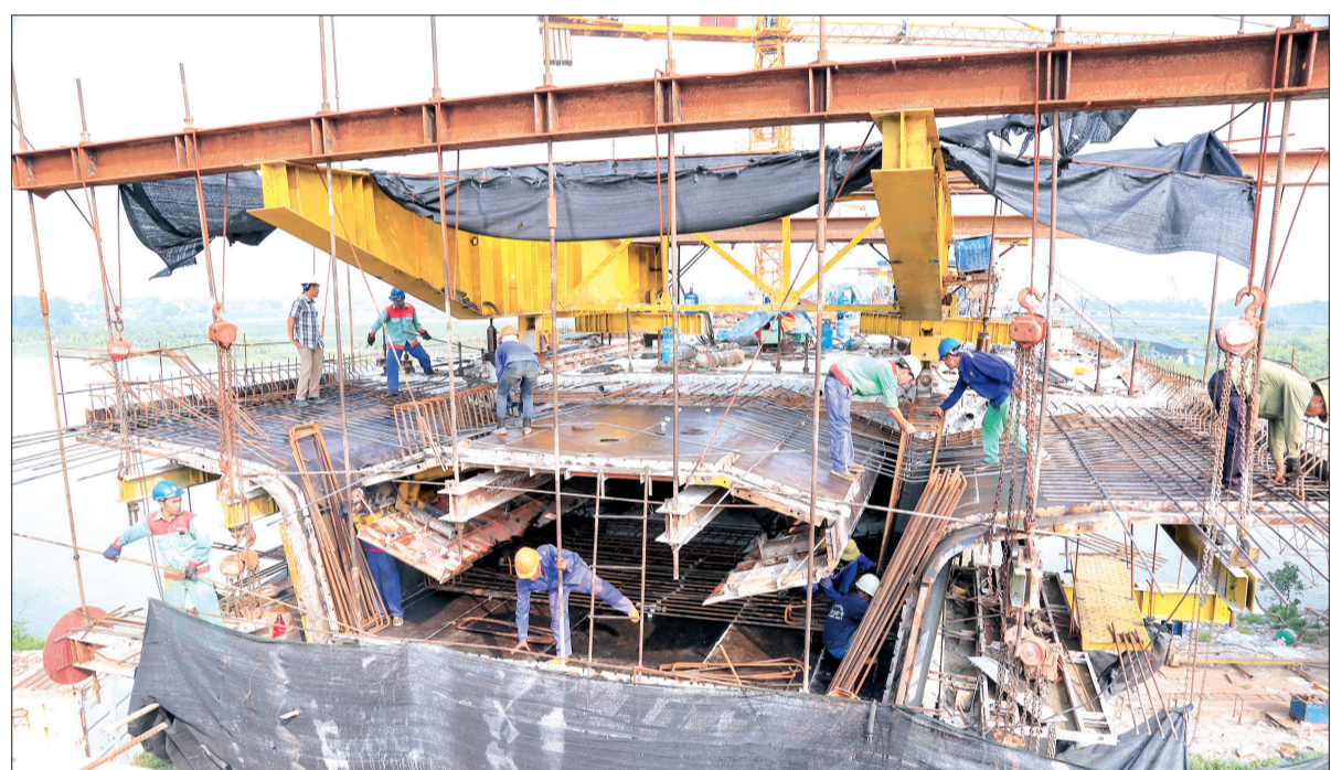
Cầu La Tiến đang được đơn vị thi công tập trung nhân lực, vật tư, phương tiện thi công, đáp ứng yêu cầu về chất lượng, tiến độ.
