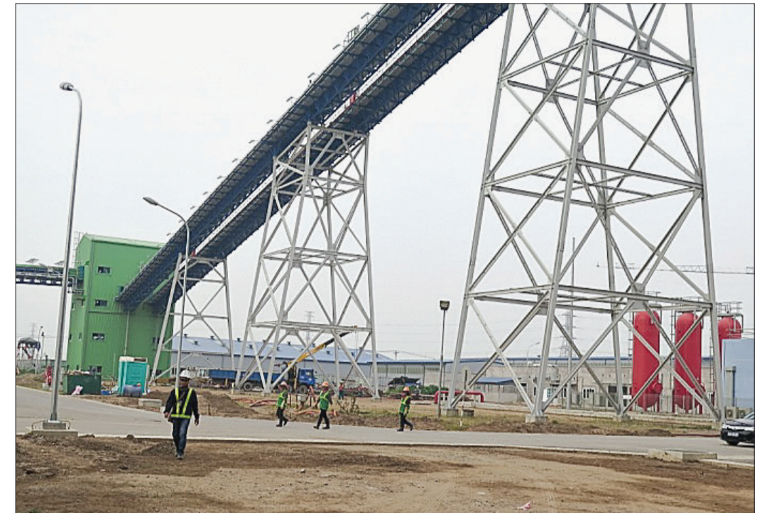
Đơn vị thi công tiếp tục hoàn thiện các hạng mục bên ngoài nhà máy.
