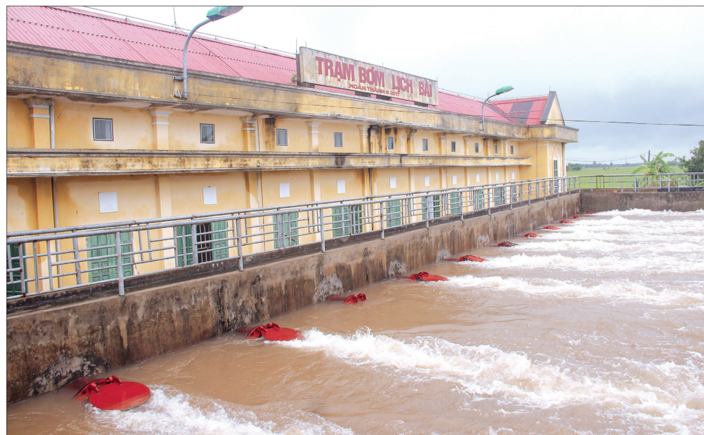
20/23 trạm bơm tạm dừng hoạt động để bảo đảm an toàn công trình trước lũ.
